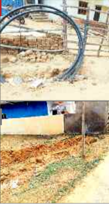
ग्राम पंचायत का अपरा निर्माण कार्य।
