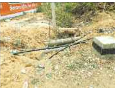
नगर पालिका और ग्राम पंचायत से बिछाए गए पाइप लाइन।
